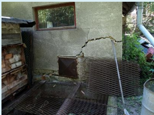
Deformace hospodářské budovy v odlučné oblasti
