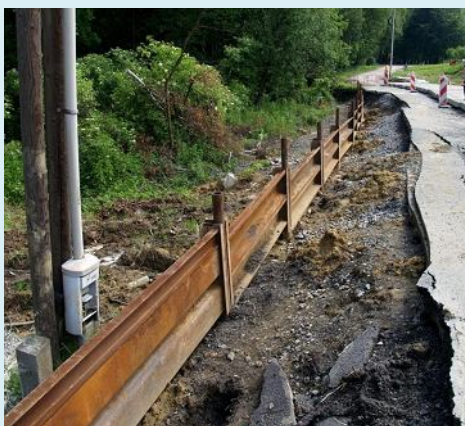
Realizace MP a osazení štětovnic
